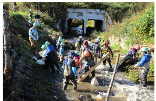
多くのサケの遡上落ち着いた11月16日にポータブル魚道を回収しました。綿製の土嚢袋と、魚道底面に浸けた布も一部破れていました。破れてはいましたが、ポータブル魚道の機能は損なわれることなく、運用することができました。今後は、布を2重にするなどの対応が必要だと感じました。
