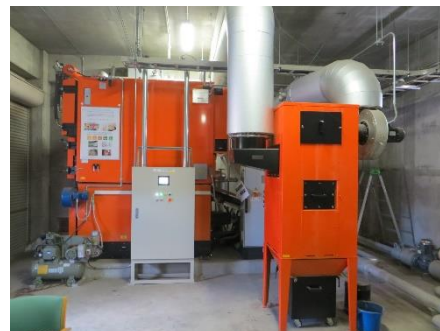
<導入設備の現地調査>
