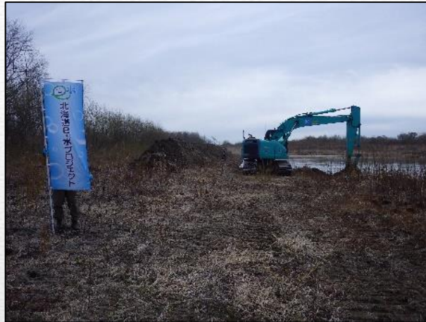
掘削状況(4月22日)
