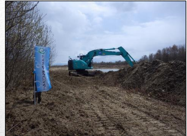
掘削状況(4月23日)
